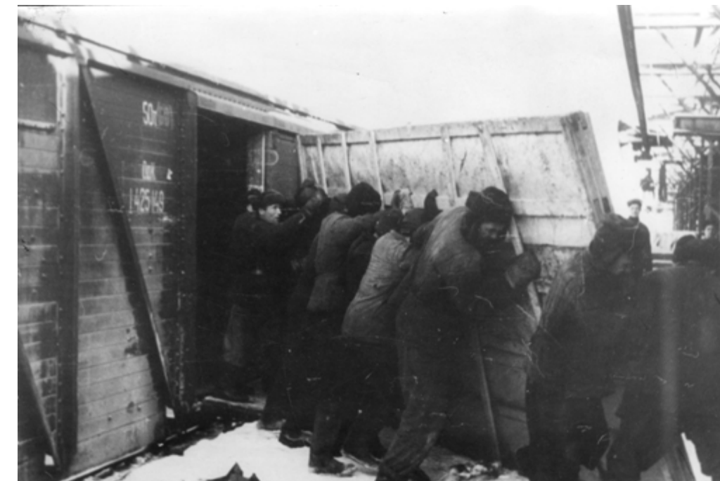
Выгрузка оборудования на новой площадке. Куйбышев, станция «Безымянка», октябрь 1941 года
