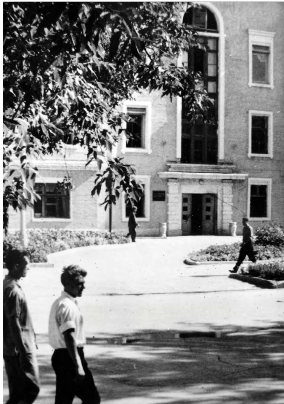
Административное здание завода, корп. 6, 1980-е гг.
